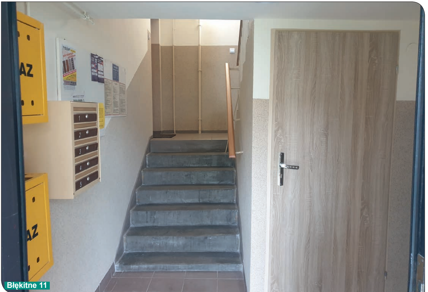
Błękitne 11 w trakcie remontu
